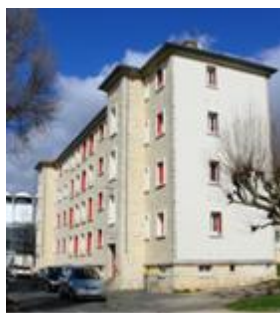
Bâtiment PN6 à Port Neuf
