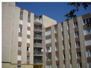
Bâtiment VLS500 à Villeneuve les Salines
